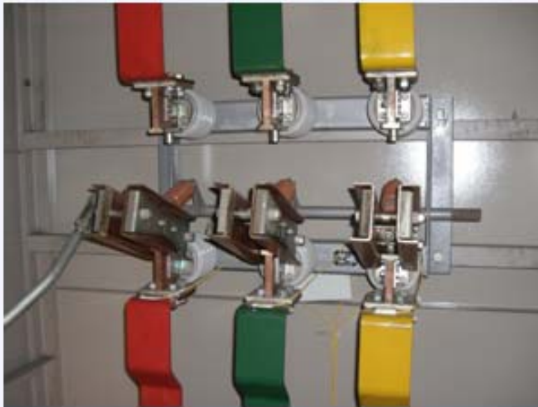
开关柜内下刀闸传感器布置图
